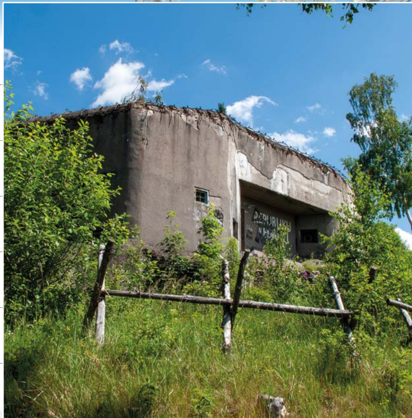
Pěchotní srub Soah u Starého Města
