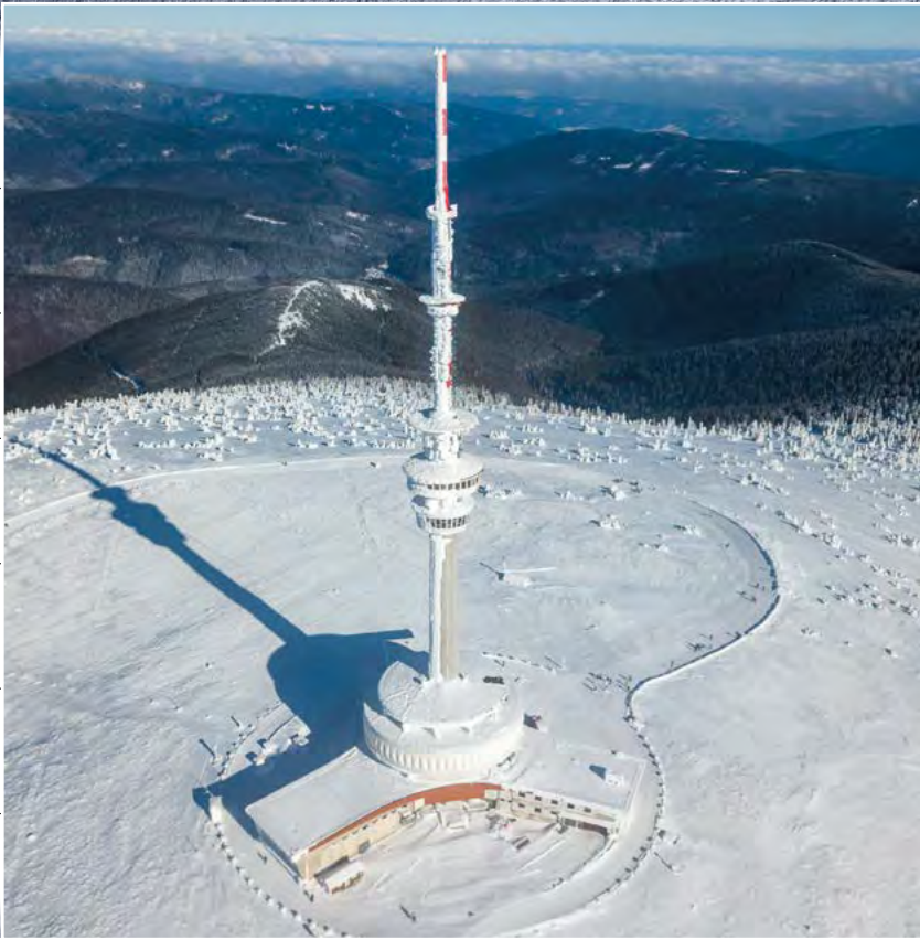
Televizní věž na Pradědu
